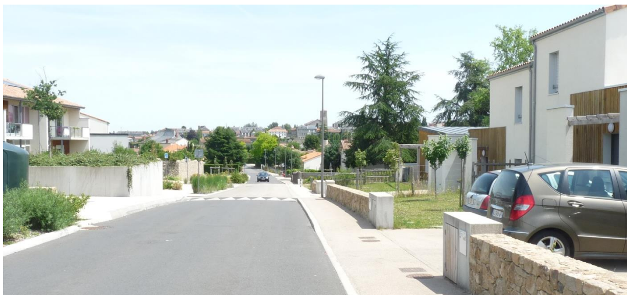
Opération bien intégrée, ménageant des perspectives sur le centre ancien de Parthenay – Source : photos © aura
